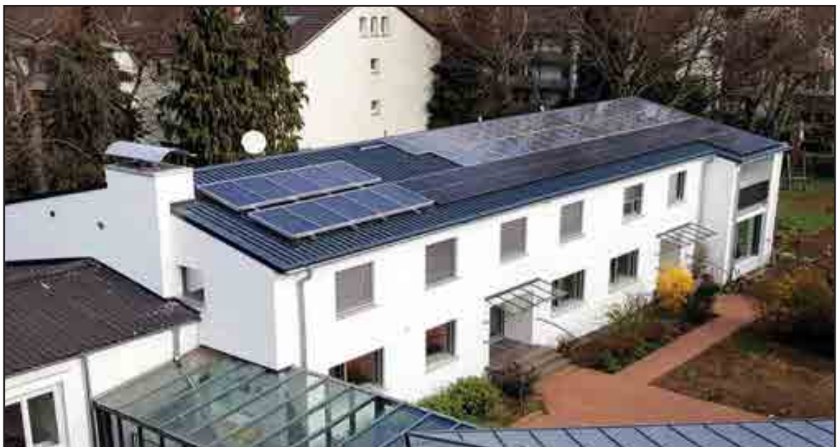
Auf dem Pfarrhaus mit Küsterwohnung und Gemeinderäumen erzeugt die Sonne in zwei Fotovoltaikanlagen und einer Solarthermie Strom und warmes Wasser.
